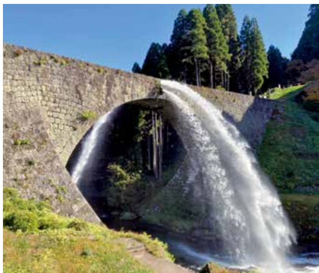
上益城郡山都町・通潤橋
