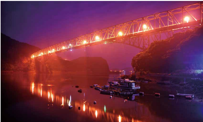
宇城市三角町: 天門橋(天草五橋・1号橋)
